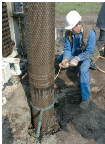
Demontage der gezogenen Filter
