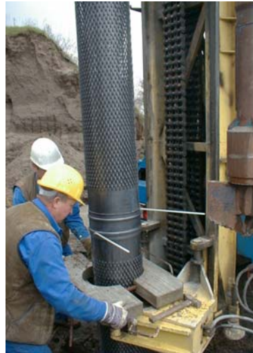
Montage der Scherstabverbindung
