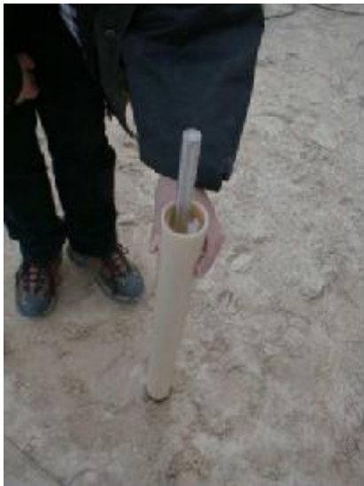
Dichtenkontrolle mittels Hydrometer
